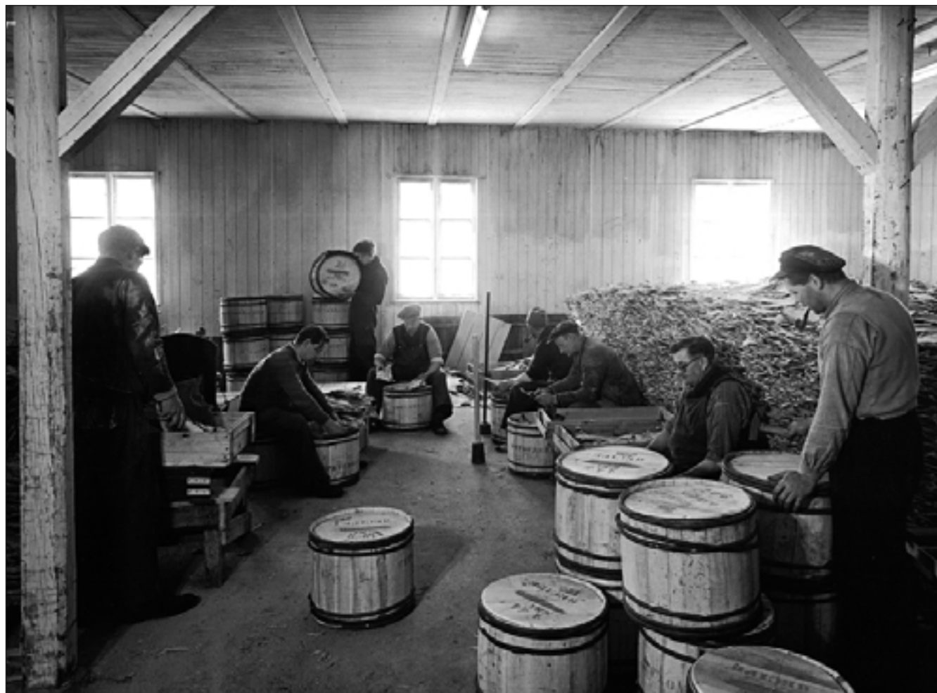
I 1947-48 blev flygtningebarakkerne i Storkøbenhavn solgt. Den evangeliske kirkebygning fra Kløvermarken genopstod f.eks. som kirke i Islev. En kirkebarak i St. Magleby genopstod som kirke i Hvidovre. Andre barakker blev opstillet som husvildebarakker flere steder i Storkøbenhavn. Den katolske kirkebarak fra Kløvermarken blev sammen med en anden barak genopført på Dragør Havn og indrettet som klipfiskefabrik. Fabrikken nedbrændte i 1965.
