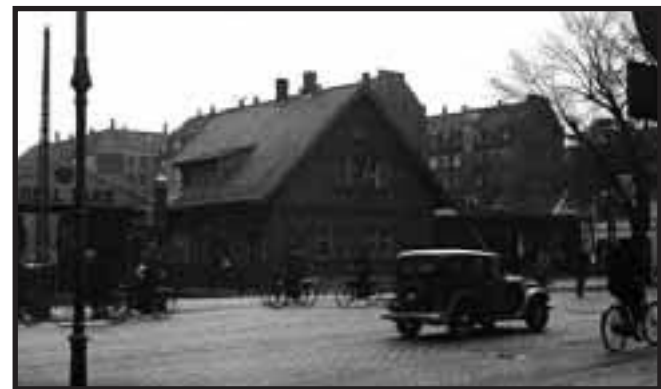
29. APRIL 1938: Statsbanernes overarkitekt Heinrich Wenck tegnede 1906-1907 stationsbygningerne til Amagerbanen. Alle bygninger var murede bygninger bortset fra Amagerbro Station på Amagerbrogade, der var opført af tømrermester Kastrup-Nielsen. Nedrivning af sidebygningen er påbegyndt kun en måned efter trafikken stoppede på Amagerbanen. Foto Erik Johansen.
