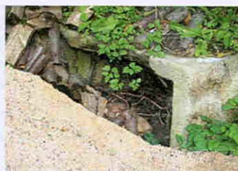
Betonmagasinet er næsten helt tildækket
