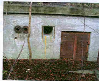
Øverst: Fundament for maskinkanonerne
