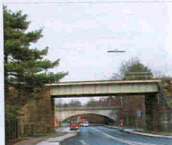
Jernbanebroen over Ermelundsvej
