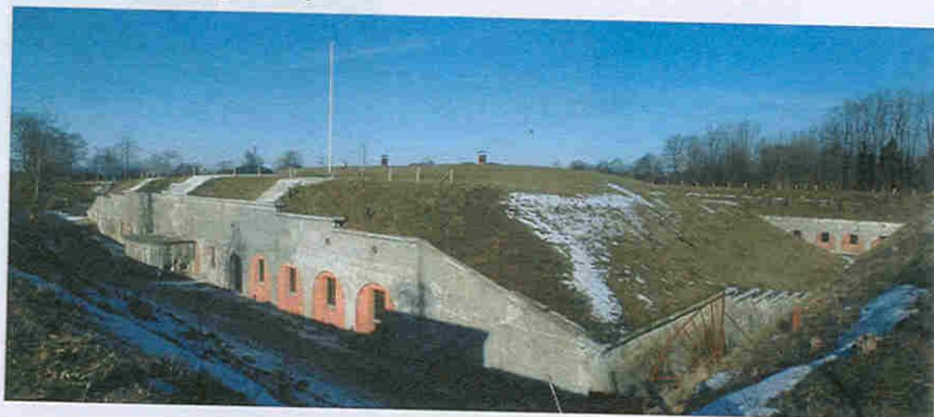
Det store fæstningsanlæg
