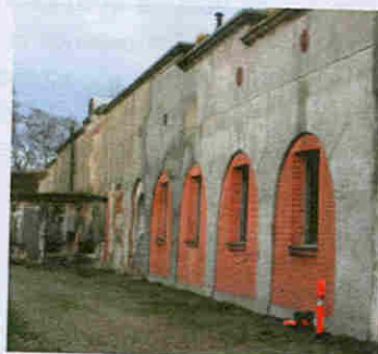
Den restaurerede del
