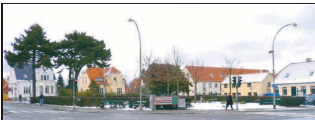
Marts 2006. Til højre for anlægget ses E.C. Hammersvej 3-19. Nr. 13-17 er skjult bag træerne. De nyere boligblokke »Lo og Lade« blev taget i brug i 1948. (Forfatterens foto).
